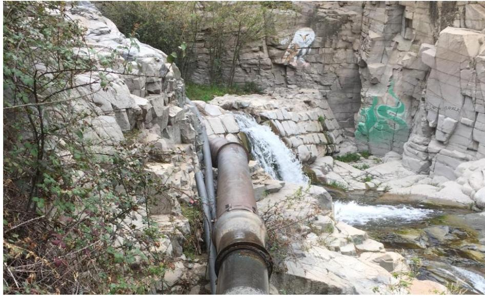
Figura 5: Tubería de aducción. Estero El Manzano
