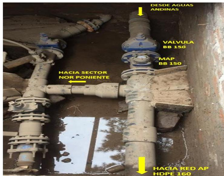
Figura 2: Cámara del macromedidor 150 mm.
