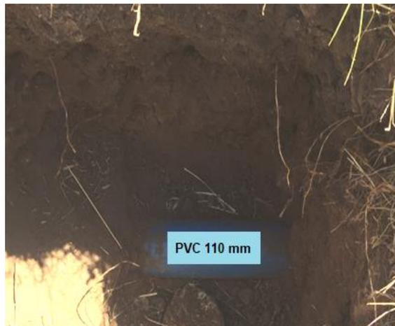
Figura 18: Calicata 2, Tubería PVC 110 mm Sector Sur-Poniente. Calle el Manzano.
