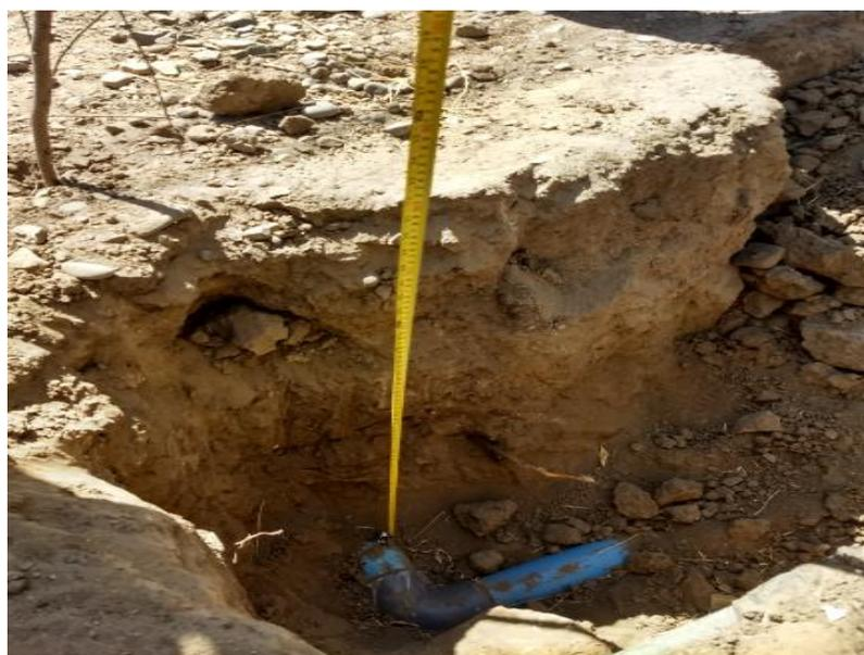
Figura 21: Calicata 4, Tubería PVC 75 mm. Calle Los Maquis, El Manzano
