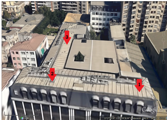
Figura 7.1. Lugares de instalación de antena.
