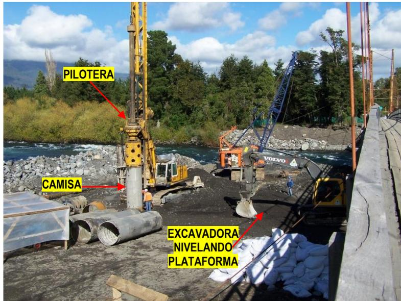
Figura 6.7: Plataforma de trabajo en Puente Quelhue, río Trancura, Pucón.
