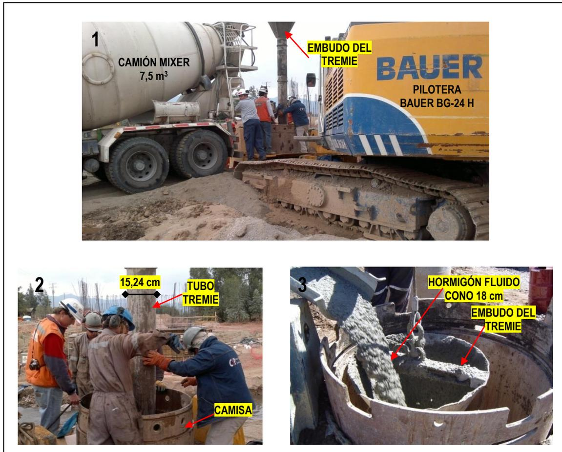
Figura 6.22: Vaciado de hormigón con uso de tubo tremie.
