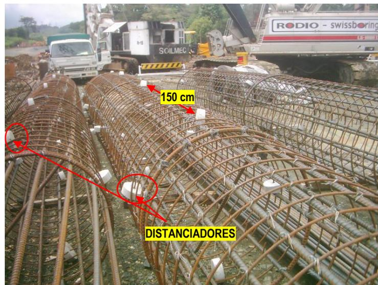
Figura 6.17: Armaduras de pilotes con distanciadores de hormigón, dispuestas cada 150 cm.
