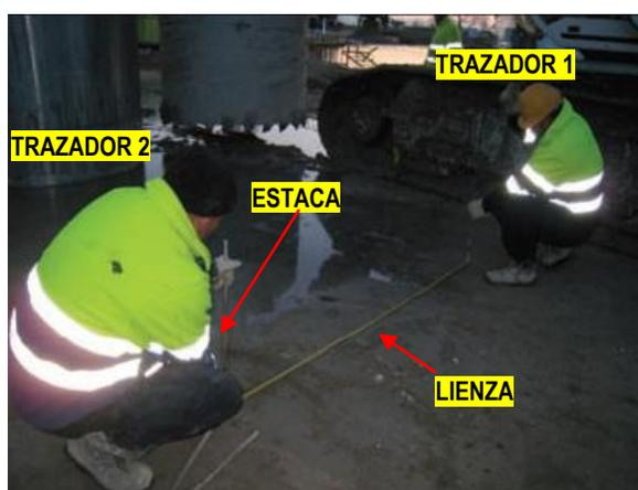
Figura 6.9: Ejemplo de replanteo con lienza y estacas.
