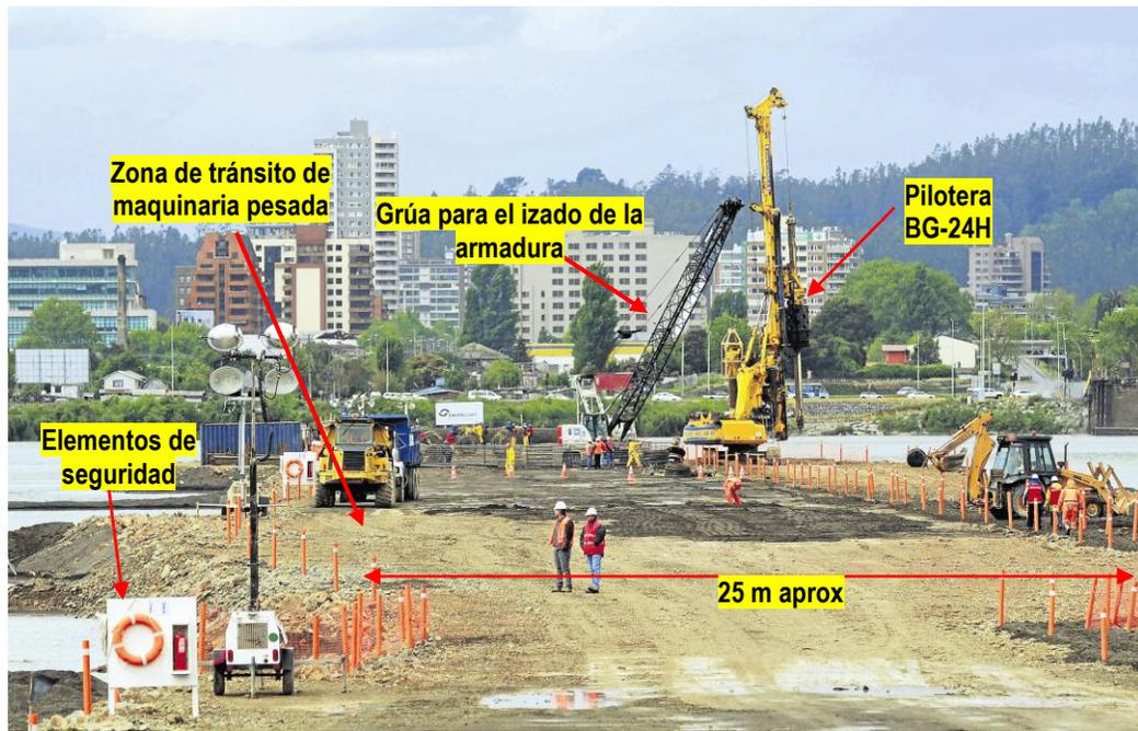
Figura 6.6: Plataforma de trabajo en Puente Chacabuco, río Biobío, Concepción.
