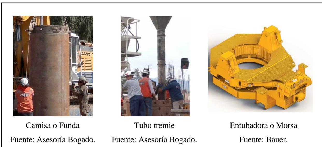
Figura 5.9: Elementos auxiliares de la pilotera.
