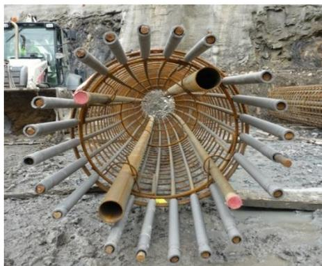
Figura 8.9: Armadura con tubos para sondeo sónico (*Cross Hole*).
