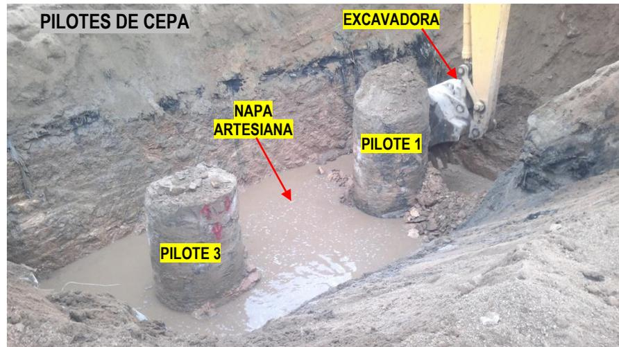
Figura 6.40: Excavación alrededor del pilote y retiro de material suelto en cepa.
