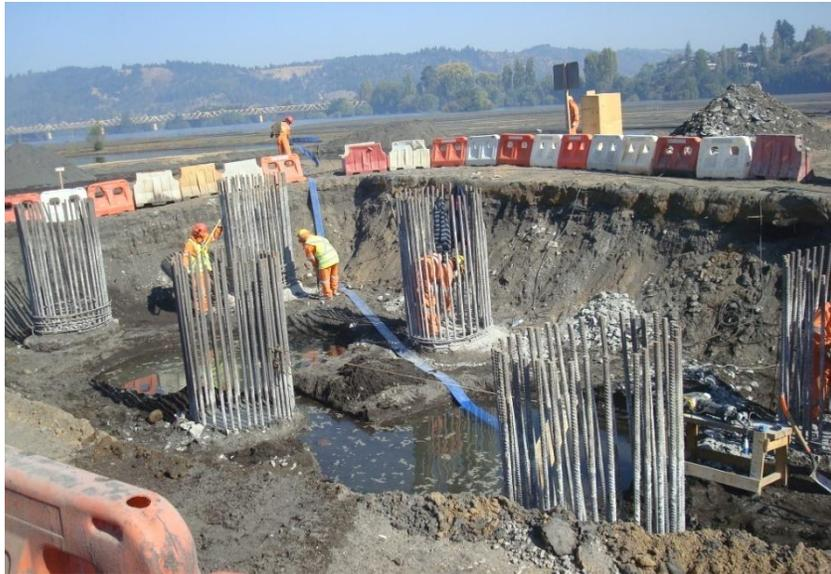
Figura 6.42: Descabezado de pilotes en Puente Laja, Región del Maule.
