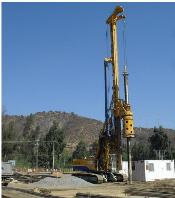
Figura 6.11: Posicionamiento de la pilotera.
