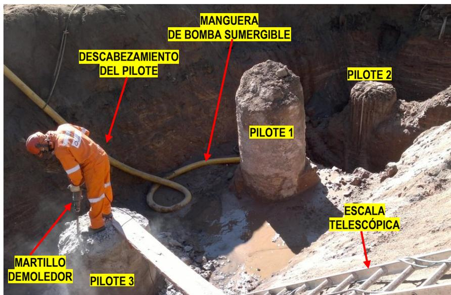
Figura 6.41: Descabezado de pilotes de una cepa, usando martillo demoledor (cango).
