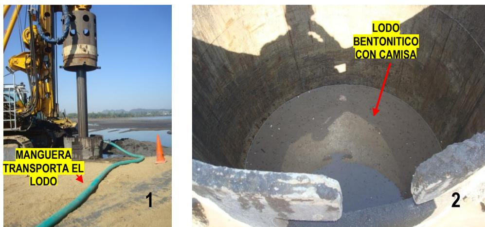
Figura 6.28: Lodo colocado en la excavación del pilote.
