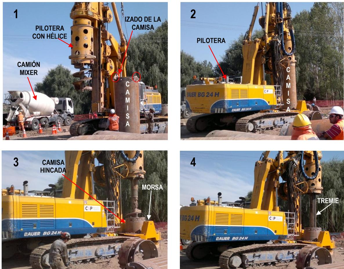
Figura 6.31: Secuencia de excavación y encamisado.
